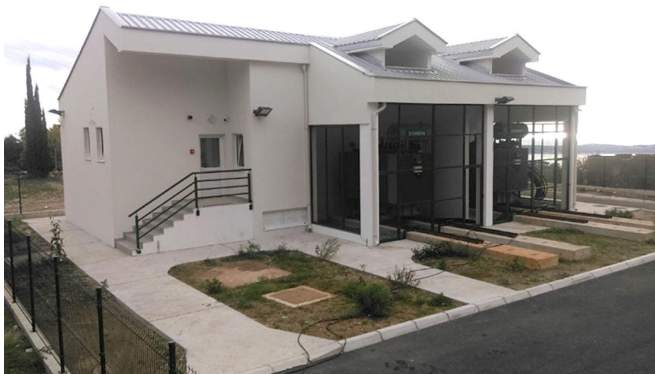
Slika 3. Primjer jedne trafostanice 35/10kV,2x8MVA
